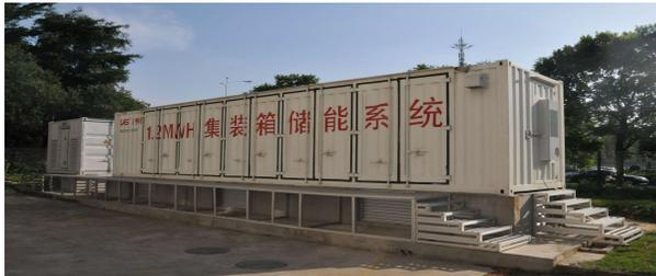
EAST 공장의 250 kW / 1.2 MWh 에너지 저장 발전소
