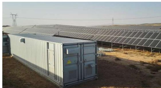
PV 시스템을 위한 에너지 저장 6 MW / 14.4 MWh 프로젝트 (닝샤)
