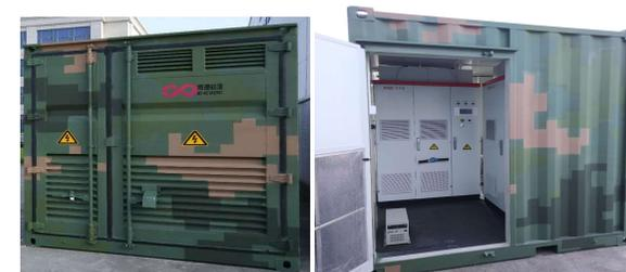
500kW / 1MWh 에너지 저장 발전소
