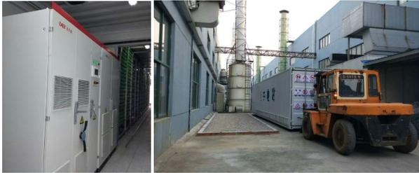
EAST 1 MW / 8 MWh 에너지 저장 발전소
